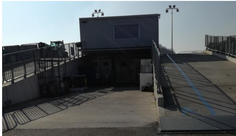
Local de stockage sous les quais
