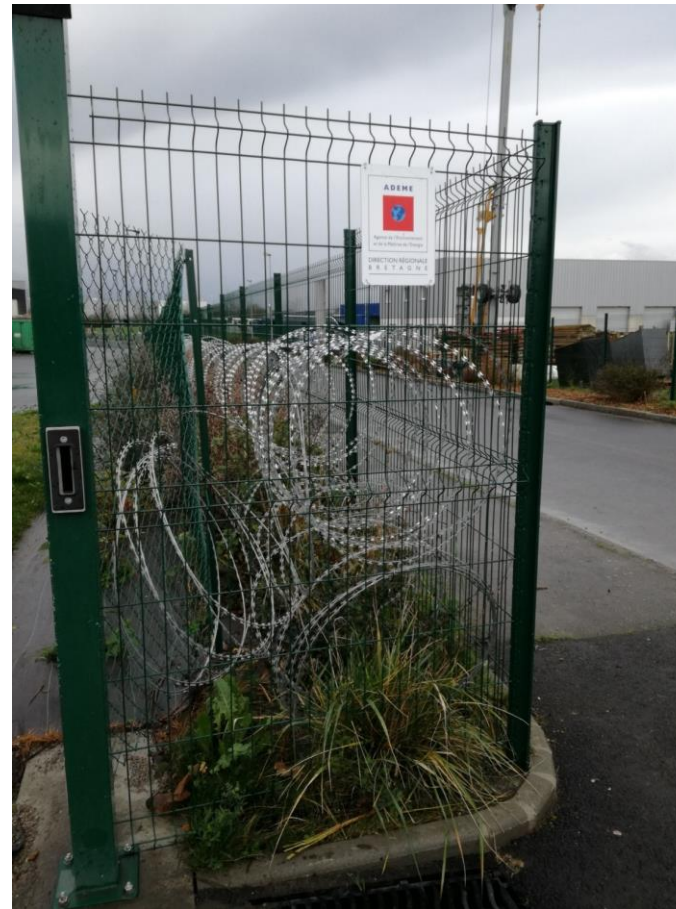
Grillage rigide anti intrusion, concertina et haie de pyracantha. Grillage souple supplémentaire à l'intérieur.
