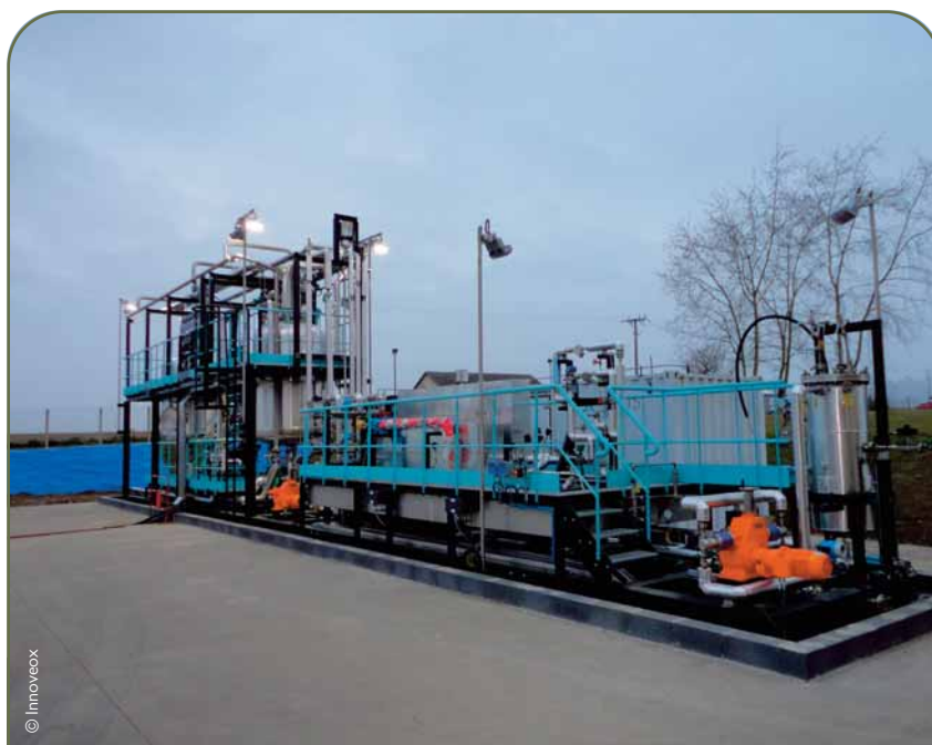
Unité de traitement des déchets par Oxydation HydroThermale en milieu Supercritique – Innoveox.
